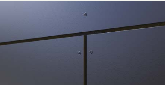
2. Kompaktlaminat- og fibercementplader: Fugerne skal være mindst 8 mm brede.
