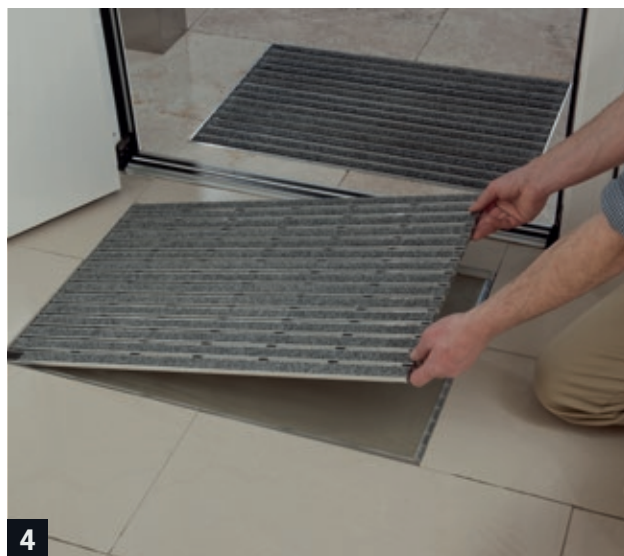
4 Når fliseklæben er tør placeres dørmåtten i rammen.
