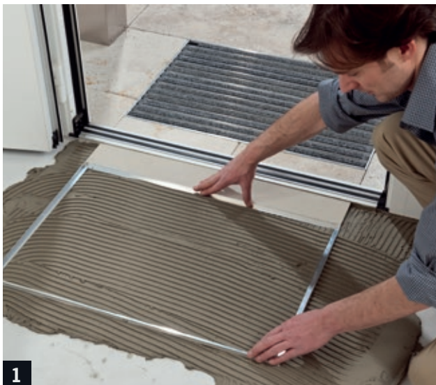
1 Placér og tryk kanrammen i aluminium fast i den udlagte fliseklæb.
