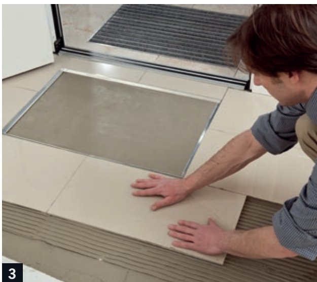
3 Tilstødende overfladebelægning lægges. Efterlad en lille ekspansionspalte mellem belægning og ramme.
