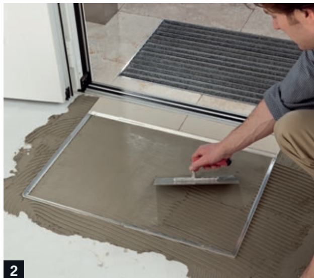
2 For at skabe en plan overflade til måtten tilrettes fliseklæben indvendigt i rammen.
