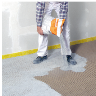
Udhældning af fermacell™ Bikubegranulat
