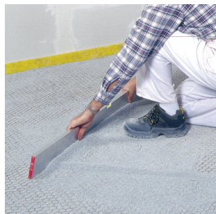
Afretning af fermacell™ Bikubegranulat
