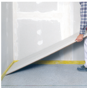
Udlægning af fermacell® Fibergips gulvelement
