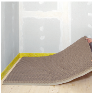
Udlægning af fermacell™ Bikubeunderlag
