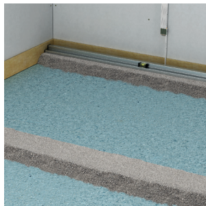
4 ... og nivelleres ud. Den anden dæmning hældes ud i samme niveau som den første og nivelleres ud.
