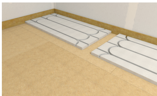
Montage af fermacell® Therm25™ gulvarmeelementer (variant 1) ved løs montage, stumt stødt og krydssamlinger.
