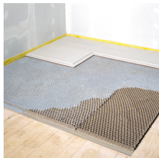
Princip for udlægning af gulvelementer på bikubesystemet
