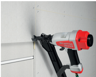
Fastgørelse af et yderligere lag fermacell® Fibergips.
