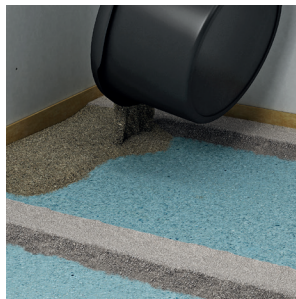
5 Vent, indtil dæmningerne er tørret. (ca. 20 minutter) Herefter udfyldes med niveaumørtel.
