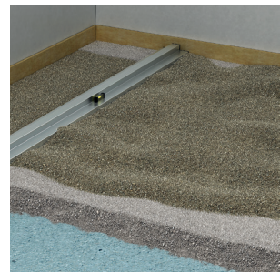
6 Når niveaumørtelen er lagt i mellem dæmningerne, jævnes der ud.
