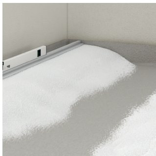
Opbygning af dæmninger
