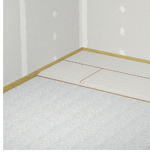
8 Udlægning af gulvelementer efter ca. 24 timer
