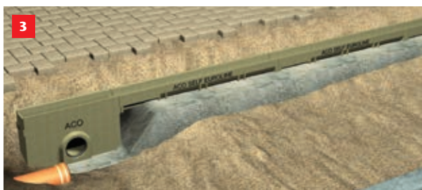
Placer rende elementerne. Start med at grave bladfanger ned i en dybde på ca. 40-45 cm. Sørg for at bladfanger bliver sat i vater. Sæt rendestykkerne sammen og sæt dem ligeledes i vater. Ønskes lodret udløb anvendes 1 m dræn med lodret udløb. Ønskes vandret udløb, monteres endevæg med vandret udløb. Se produkterne på side 9.
