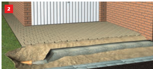
Støb fundament. Betonen hældes i renden. Blandingsforhold: ca. 1/3 cement og 2/3 grus. Betontykkelse min. 10 cm. Vær opmærksom på udløbets placering.
