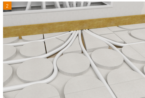
Skær elementer til, så der er tilstrækkelig støtte af den overliggende fibergipsplade.
