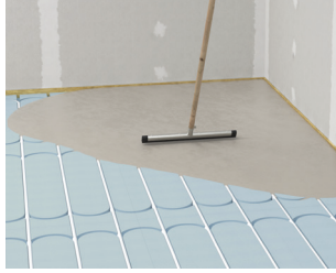
Opfyldning af Therm25™ elementerne med fermacell™ spartelmasse
