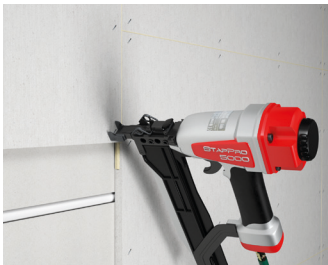
Fastgørelse af et yderligere lag fermacell® Fibergips.
