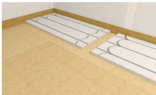
Montering af fermacell® Therm25™ elementer (variant 1) ved løs montering, lige stød og krydssamlinger.
