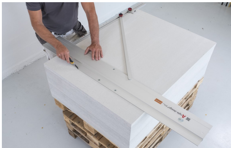
2. Ved skæring med kniv vendes føringsskinnen og den modsatte side anvendes. Den fastsatte mållinje passer fortsat selvom føringsskinnen vendes.
