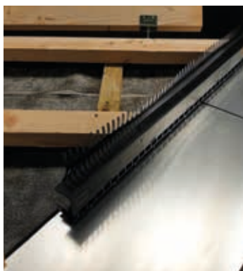
1 IcoVenti skotrendeelementer monteres fra kippen og ned mod tagfoden.
