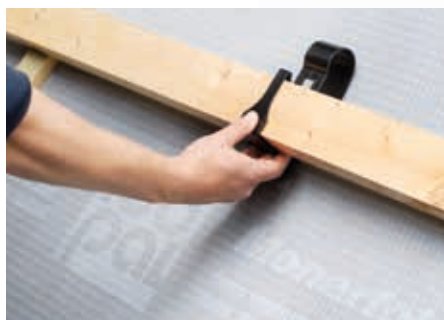
IcoTens klikkes fast på lægten nede fra.
