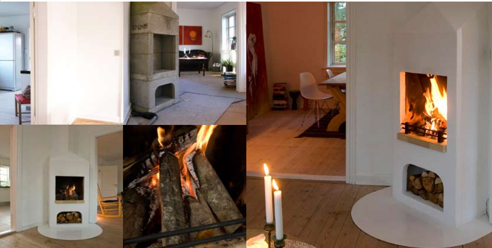
Denne pejseløsning er bygget op gennem gulvet med udgangspunkt i kælderrummet. En nødvendighed da trægulvet ikke kan bære vægten af pejs og skorsten.
