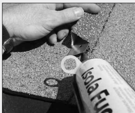
Fæsteskive (t= 1 mm) 36x55 mm, Skruer 5x35
