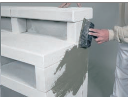
5. Overfladen spartles.
